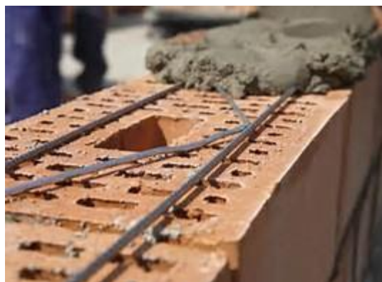
Placement d'une armature
