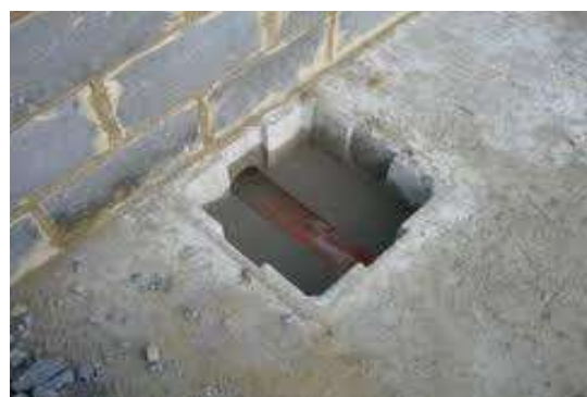
Chambre de visite intérieure
