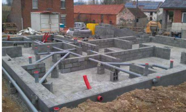
C'est là que le maçon intervient, lors de la construction, il doit poser le réseau destiné à évacuer ces eaux. Le réseau est mentionné sur plan, nous avons déjà eu l'occasion de le repérer lors de notre découverte du plan.
