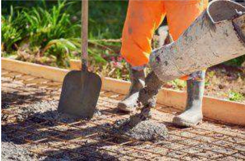
*Treillis soudé pour dalle béton*
