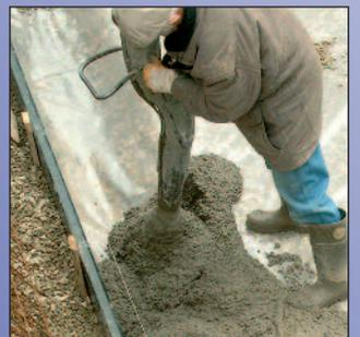
Coffrer = poser le tuyau de drainage → pas de bois de coffrage → moins de travaux !
