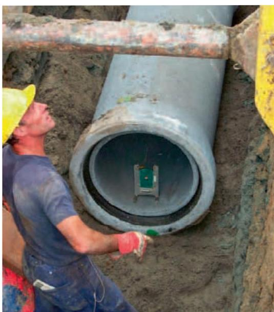
Chaque fois que l'on pose une canalisation, il faut donc emporter la plaquette de visée et la poser dans la canalisation pour contrôle. Attention : la plaquette de visée doit toujours être parfaitement horizontale pour permettre d'effectuer le contrôle.
