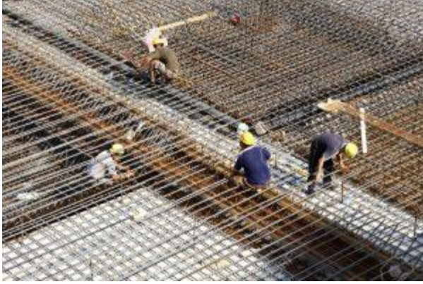
Façonnage d'armatures sur chantier.
