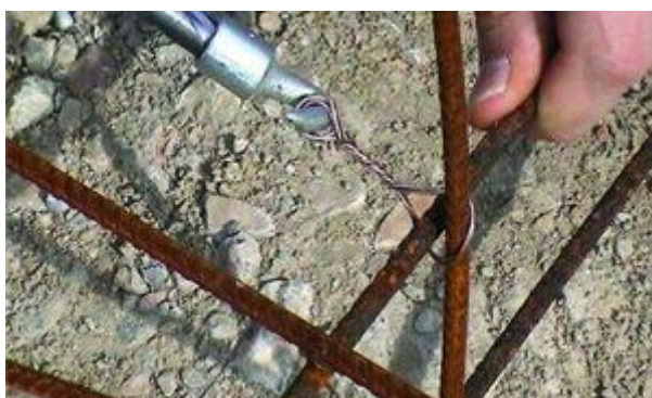
Ligature des treillis soudés.
