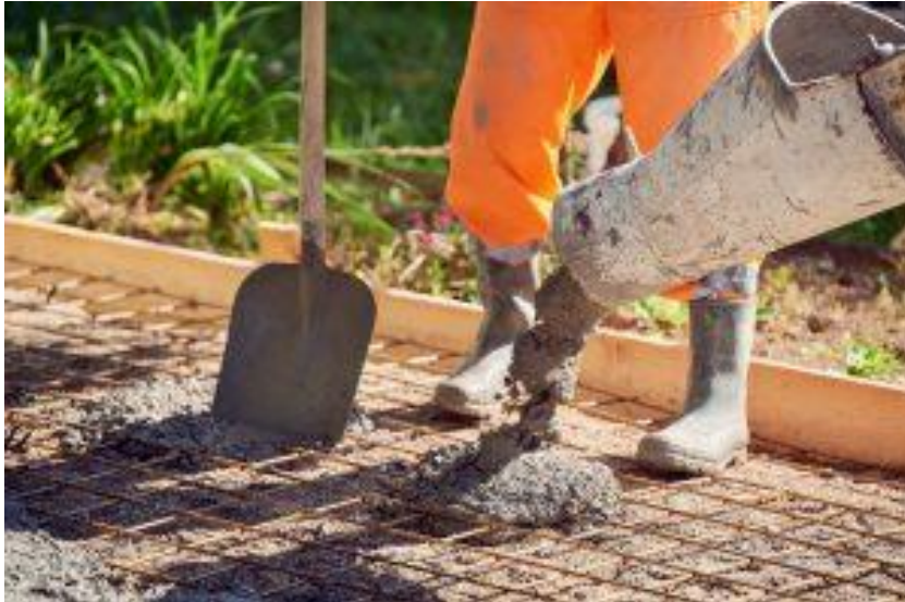
Treillis soudé pour dalle béton
