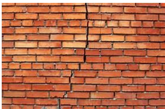
Maçonnerie sans armatures
