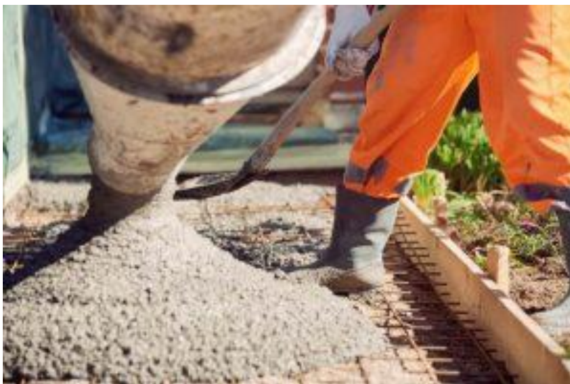
Coulage du béton.
