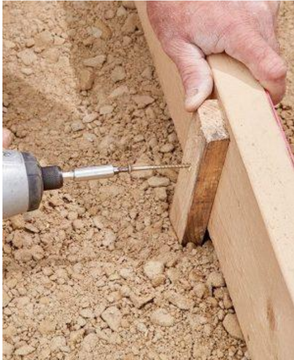
Fixation du coffrage.
