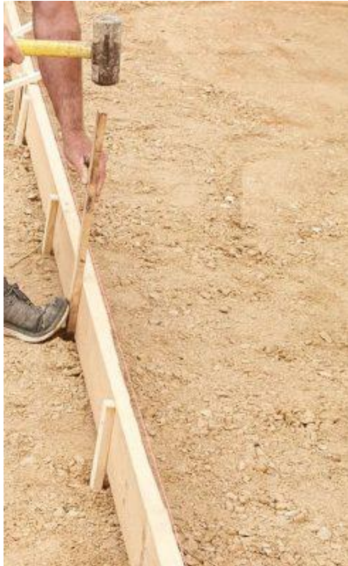
Pose du coffrage.
