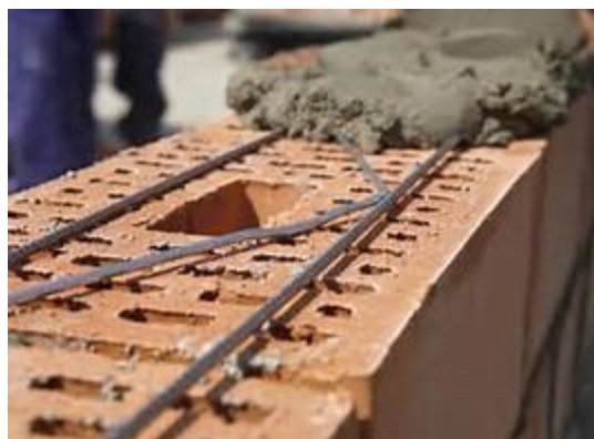
Placement d'une armature
