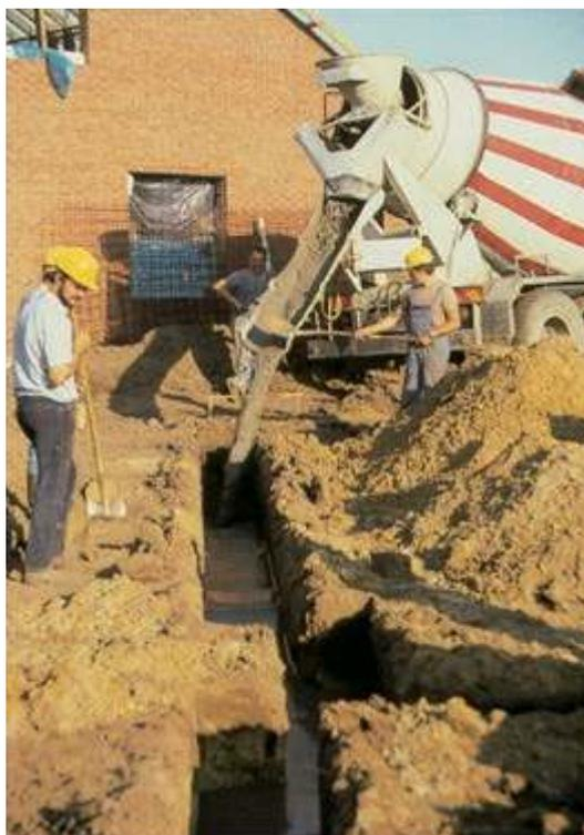
Le béton est coulé dans la tranchée de fondation.
